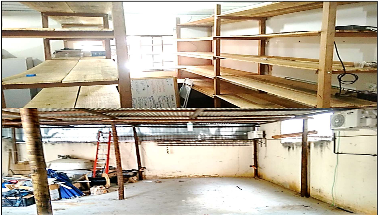
Figura 13 - Sala e Galpão após limpeza
