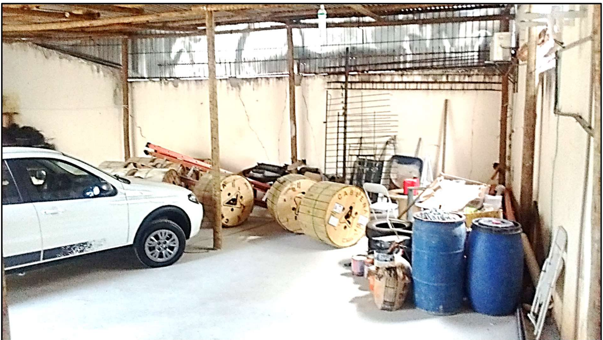
Figura 9 - Galpão com bobinas em contato com o chão, lixo e estrutura frágil
