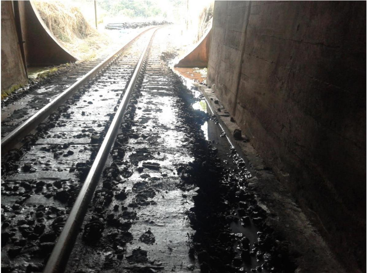
**Figura 6: Contaminação nos Lastros Impedindo a Verificação da Condição de Dormentes e Trilhos**
