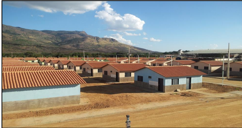
Figura 9: Obras praticamente concluídas no Residencial Vitória. Fonte: Arquivos da Empresa Diretriz.
