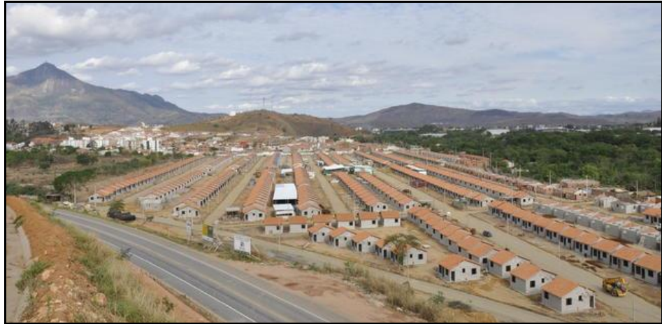
FIGURA 8: Obras em andamento do Residencial Vitória. Fonte: Site da Prefeitura Municipal de Governador Valadares.
