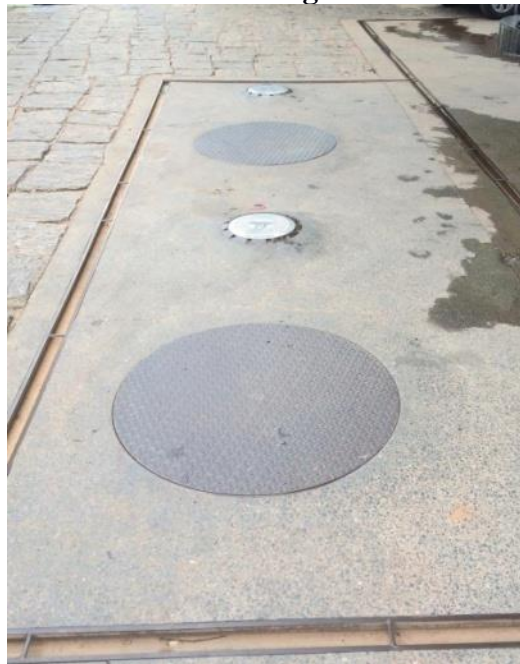
Figura 6 – Área de descarga de combustível 01
