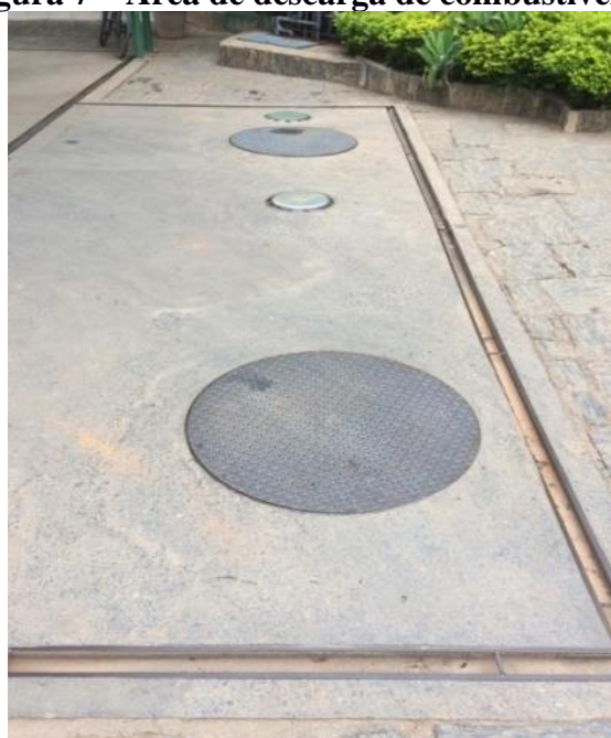
Figura 7 – Área de descarga de combustível 02
