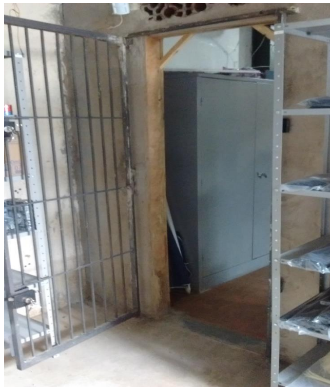
Figura 16 – Porta de acesso ao estoque externo. Fonte: Autoria própria (2015).
